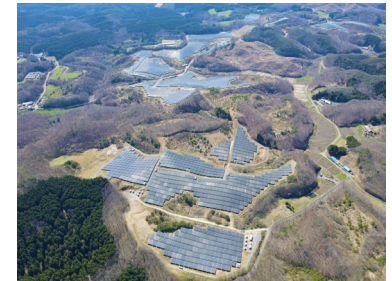
鮫川青生野太陽光発電所
